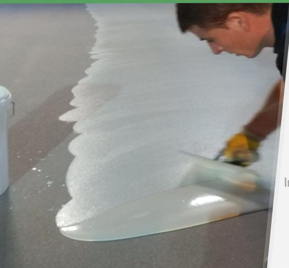
**TRICO BAR PAVA** è un prodotto epossi-cementizio tricomponente multifunzione, emulsionabile in acqua specifico per supporti umidi.
