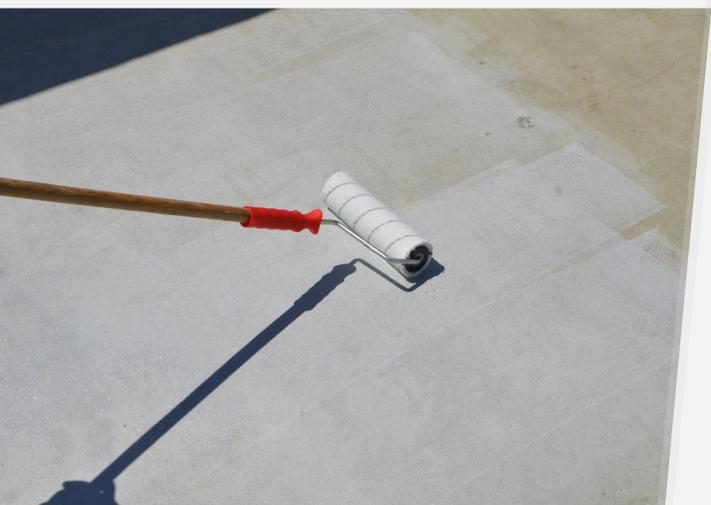
**POLIFIX PAVA** è il nuovo promotore di adesione ad alta adesione per cicli impermeabilizzanti.
